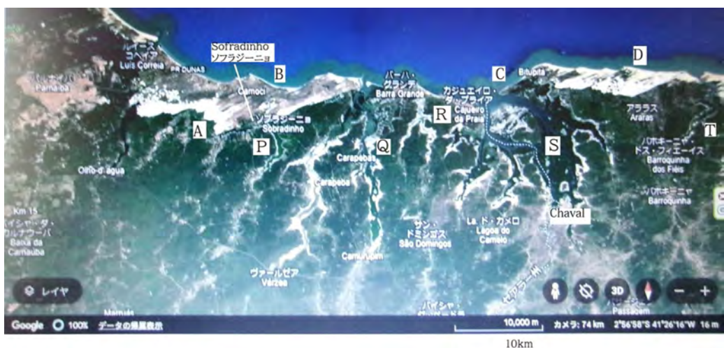
図8 Sofradinho 村・Chaval 村間の海岸の光景 B点、D点付近に長い津波堆積物からなる evron dune が見られる。P～T点の5カ所には、先行した河川の流れを津波堆積物が堰き止めて形成されたとみられる「ダム湖」が出現している様子が見て取れる。
