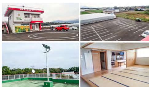
図 13 東串良町防災センター(左上:センター建物とヘリポート, 右上:車避難を考慮した駐車場, 左下:排水のための傾斜を設けた屋上, 右下:畳室と炊事場)
