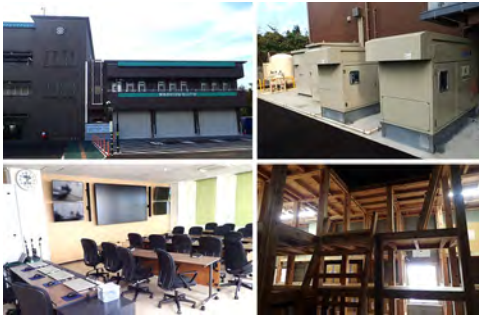
図 16 東串良町防災庁舎（左上：2 階建ての防災庁舎，右上：非常用発電機，左下：対策本部室，右下：備蓄倉庫）
