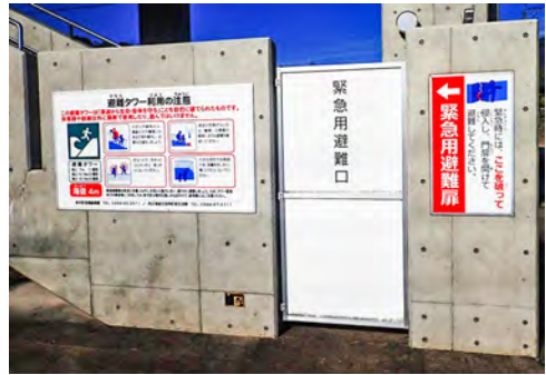
図 25 南方地区津波避難タワーの蹴破り式簡易入口
