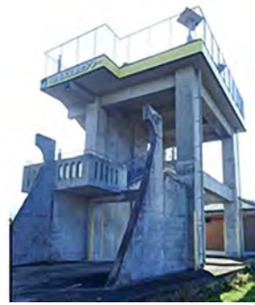
(a) 東串良町の下伊倉津波避難タワー
