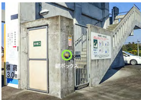
図 24 下伊倉津波避難タワーの蹴破り式簡易入口と鍵ボックス
