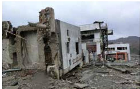
写真-3 女川町でのコンクリート建物被害。建物基礎の損傷が見られる（著者撮影）
