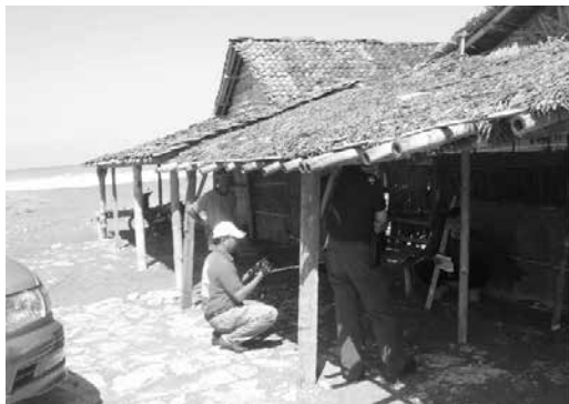
Photo. 24 Pandansari 浜 右写真, 竹編みフェンスの下方の白く変色している部分が海水浸水があったことを示している 右側写真に写っているのは Fachrizal 氏である
