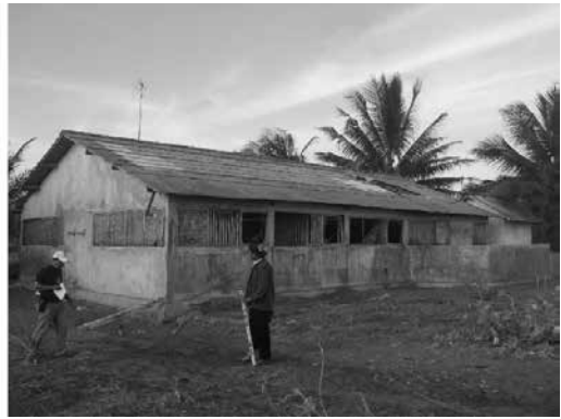
Photo. 12 Suwuk 浜の津波被災の光景 (左写真) この写真の右端の遠景に前項の Karanbolong の海岸が写っている この右写真の工場の屋根の先端まで海水が上昇した また津波のために屋根の一部が吹き飛ばされ、屋根に穴が開いた
