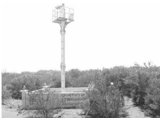
Photo. 23 Tumasari 海岸の灯台 この灯台を囲むコンクリート床面が 7cm の厚さで津波が冠水していた これは滞留水によるものである 右側写真に写っているのは韓氏である
