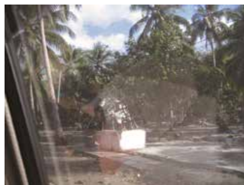
Photo. 1 津波に被災した Batukaras の集落 右の住宅は流失してコンクリート床のみが残っている
