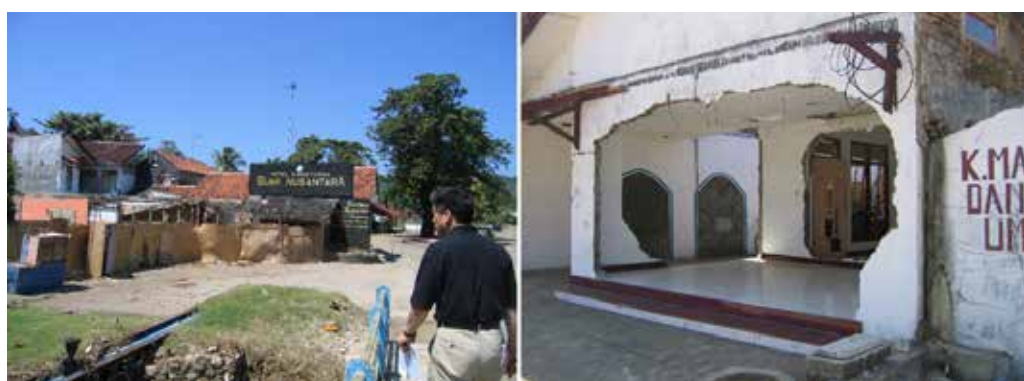
Photo. 3 Pangandaran の Bumi Nusantara Hotel の外観（左）と内部（右） 屋根は無事であったが、部屋の内側は天井近くまで浸水が達し、壁面はほぼ全面的に流失していた
