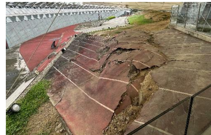
小学校校庭に現れた断層のずれ
