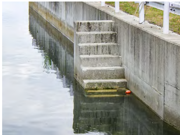
写真 18 舞根漁港の状況。階段上に堆積物やその他の漂着物は認められない。
