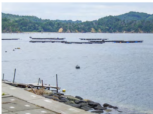
写真 12 鶴ヶ浦突端地点の状況。カキ養殖筏に破損等の異状は認められない。
