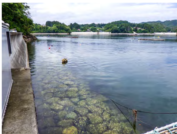
写真 3 亀山地点の状況。写真左奥の方向が西で、大橋がある。
