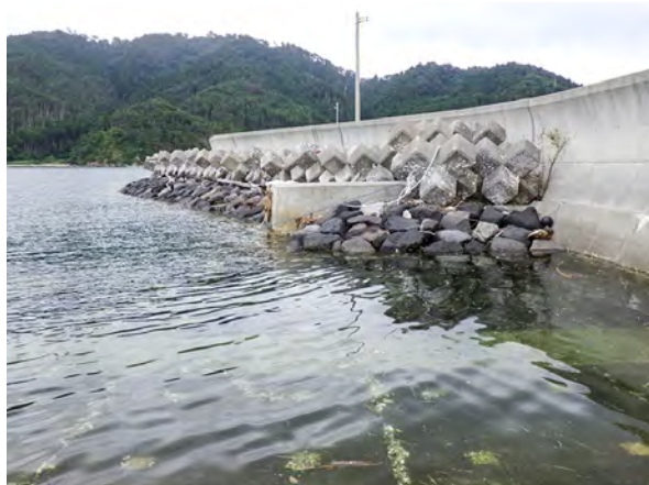
写真 15 鶴ヶ浦突端地点、護岸外側の状況。
