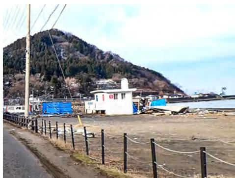
写真13 津波痕跡高を計測した公衆トイレ
