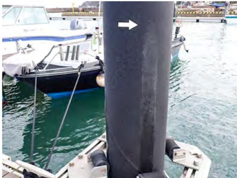
写真 21 ゴムによる傷のクローズアップ
