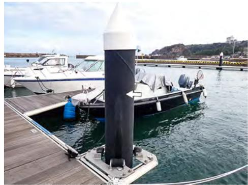
写真 20 栈橋支柱のゴムによる傷
