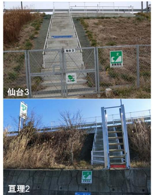
図1 高速道路の津波避難階段（仙台3（フェンス型）と亘理2（はしご型）の設置例）
