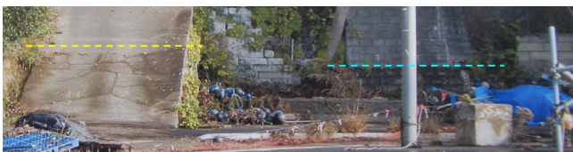
図3 東松島市大浜漁協での遡上高と浸水高 (写真提供：宮城県漁業協同組合宮戸支所)
