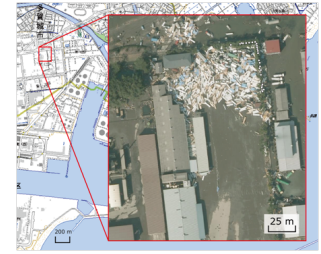
図-6 津波漂流物捕捉状況(多賀城市)
