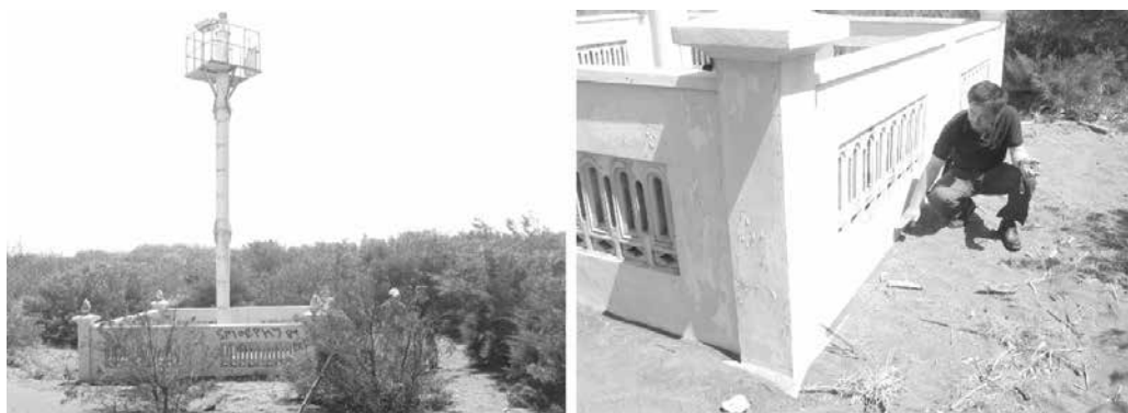
Photo. 23 Tumusari 海岸の灯台 この灯台を囲むコンクリート床面が7cmの厚さで津波が冠水していた これは滞留水によるものである 右側写真に写っているのは韓氏である
