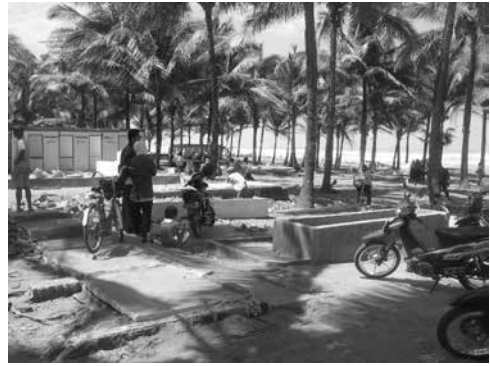
Photo. 8 Binangun 村 Widarapajung の海岸集落の津波被災状況 津波のため家屋が流失して、土台と風呂だけが残っている
