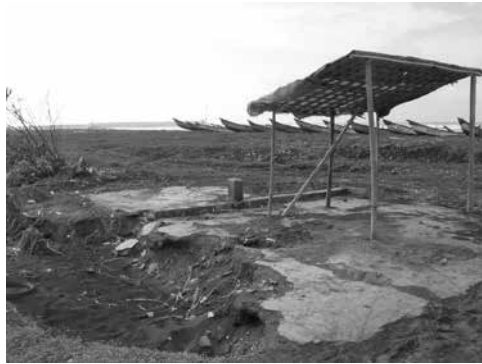
Photo. 6 Cilacap 市 Mangati-Kisik の海岸 津波によって流失した家屋跡 コンクリート床面の浸食が見られる
