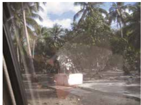
Photo. 1 津波に被災した Batukaras の集落 右の住宅は流失してコンクリート床のみが残っている
