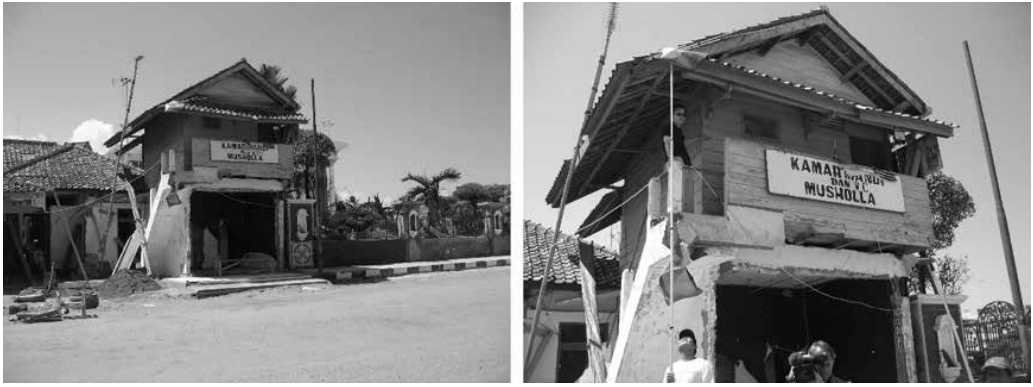
Photo. 2 Pangandaran の Musholla 休憩所 二階は浴室で、右写真の黒い上着の人が指さしているところに津波痕跡が観察された この浸水高は 8.4m であって、今回の津波の浸水高の最高点である
