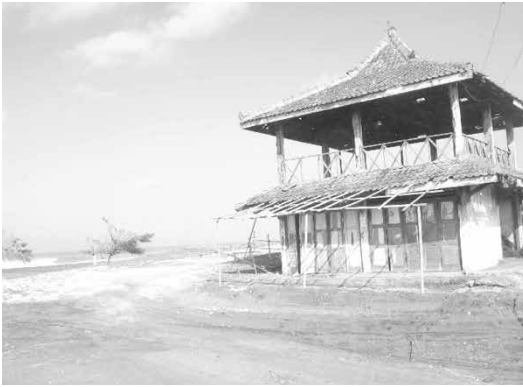
Photo. 18 Congot 海岸での調査 津波によって海水はこの建物の敷地から約 1.0m の高さまで浸水した
