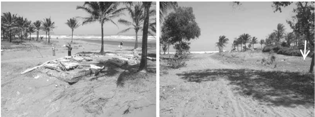
Photo. 9 Karangpakis の流失家屋跡 (左) 右写真矢印のところに津波限界を示すごみの列がある 右写真中央付近に左写真の家屋跡が見える
