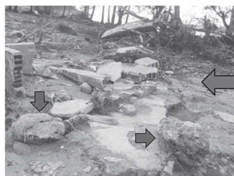
写真2 Tanjung Lesung Beach 半島での津波痕跡、沿岸からの強い波力(左向き矢印)により破壊された住宅と周辺に移動した珊瑚岩(下向きと右向き矢印)
