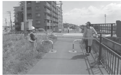
図10 笠神新橋 直上流左岸 管理用通路幅 3m
