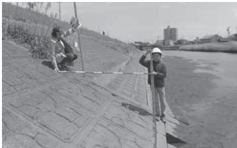
図12 鎮守橋直下流 左岸護岸勾配 1:2.0
