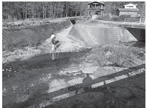
写真15 追内川の河床標高の測定調査
