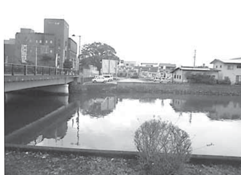
写真7 測定点の駐車場を対岸から見た光景
