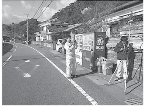
写真 16 延岡市東海の道路面測定
