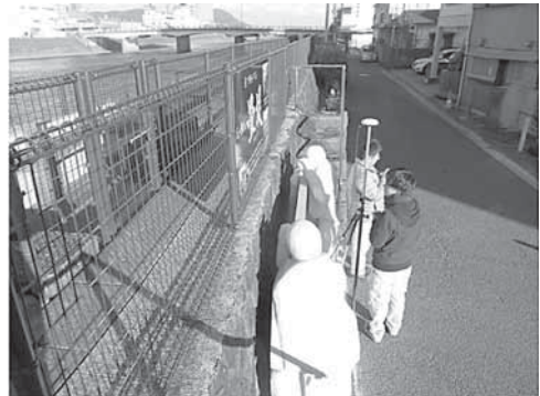
写真 18 板田橋南側旧堤防測定点
