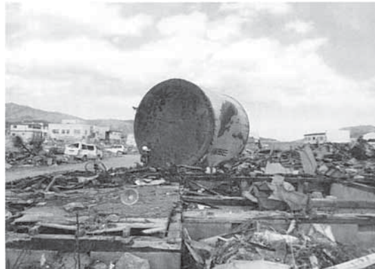
写真 2 岩手県山田町川向町での石油タンクの倒壊 (消防庁消防研究センター, 2011)
