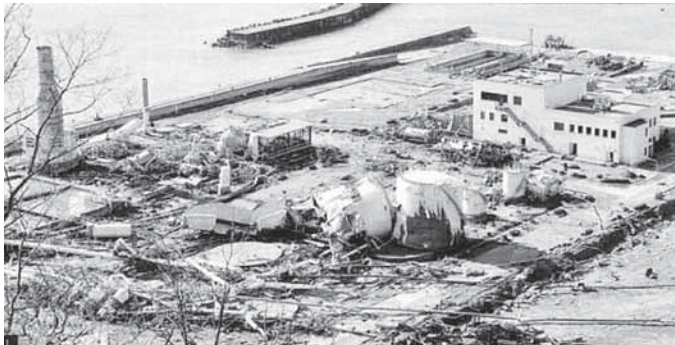
写真 3 久慈国家石油備蓄基地（久慈市夏井町半崎）で倒壊した準特定タンク 吉田ら（2012）による
