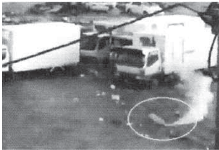
写真 1 津波が引いたときに閑上地区で撮影された LPG ガスボンベから可燃ガスが噴出している写真（消防庁、『火災報告書』, 2011 による）
