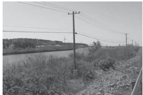
写真 2.3 電柱間隔確認 (図 3②) 電柱と電柱の間隔は 30 ~ 50m (現地確認)
