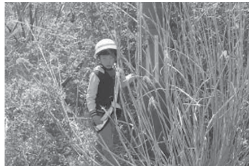
写真 2.2 電柱高さ測定状況 (図 3②) クノイダルボアの写りに撮影されている電柱の高さは、5m スタッフの 2 倍 ( \div 10\text{m} ) であった。
