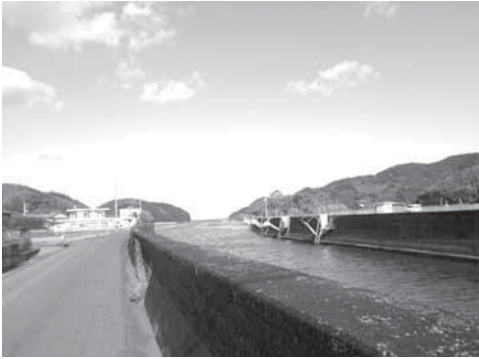
写真 20 椿川河口 水面と左側水田とほとんど標高差が無いことに注意
