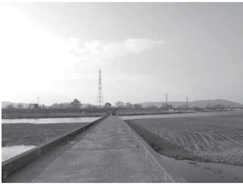
写真 8 小松島市江田, 勝浦川に架かる江田橋
