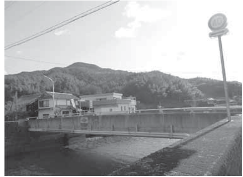
写真 21 椿川河口の八幡橋と横尾集落
