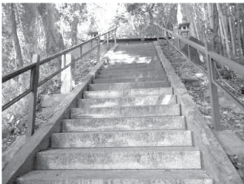
写真 14 稲田神社石段石碑 右手すり外側に見える
