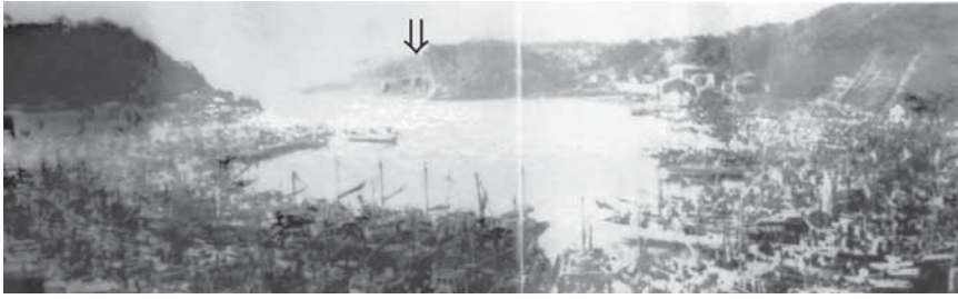
写真 6 波浮港昭和初期の写真 矢印の所に切り立った柱状の露岩が 3 個見える。さらによく見ると露岩 3 個は崩壊地を表す淡色の部分に取り巻かれている地形が見える。
