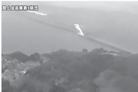
写真-8 湾口防波堤
