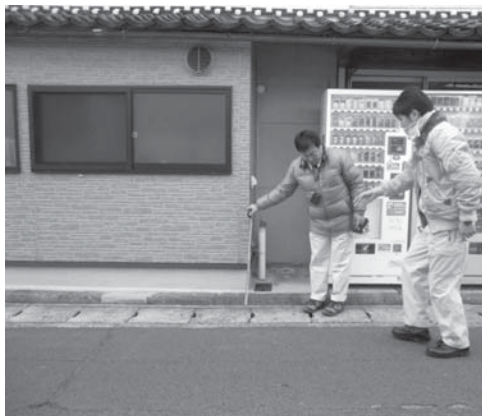
写真2 西郷郵便局周辺の市街地では，道路面上方約40cmで家屋の玄関の土間面に達する「浸水家屋」は少なくともこの高さまでは浸水したと考えられる。
