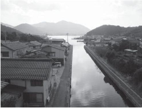
写真 12 西の島町美田船越の船引運河
