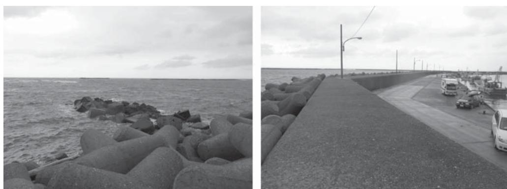
写真 14 出雲崎港南側堤防(図 23 の AB の部分) この部分がもとの「島」の上に築かれたことは、左の写真に見られるように、あちこちの基盤の岩が露出していることから伺い知ることが出来る。左に見える海域がほぼ大潤の水域に当たる。
