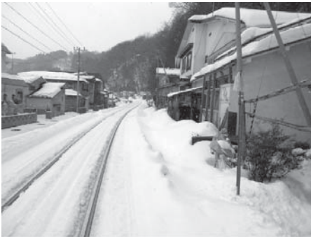
写真 26 JR 五能線の線路によって縦裂きになった旧鴨村の市街地
