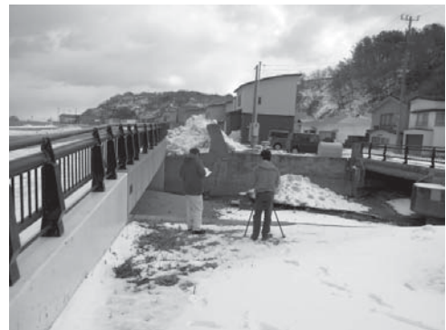
写真 31 田野沢の清滝川国道橋西側での地面標高測量
