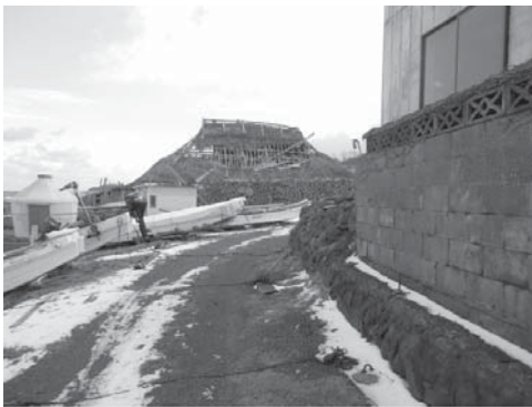
写真 38 測定した廃屋（向こう側の大屋根の家），この大屋根の家の位置に あった一軒が全壊したと考えられる。
