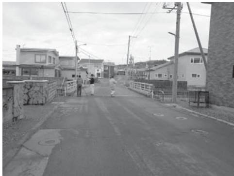
写真 34 江差町五勝手の武者見橋
