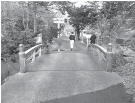
写真 11 江良八幡宮手前の橋
