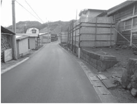
写真 32 原歌の海岸道路
