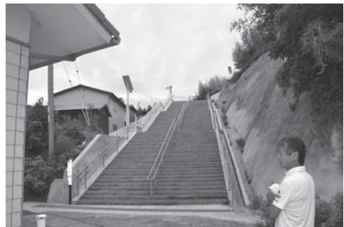
【写真4】印南小学校から高台への避難階段
