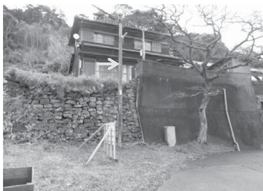
写真4 電柱に記されていたという、昭和南海地震津波（1946）の浸水高さ（図中矢印）
