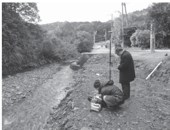
写真 5 安指川墓地での測量地点写真
