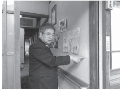
写真1 尾崎氏宅の壁面修復跡，チリ津波（1960）はここまで浸水した。
