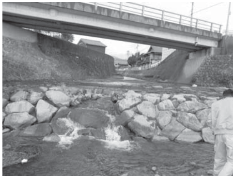
写真7 和口川が僧都川に合流する点。標高はこの段の下側の水面を測定した
