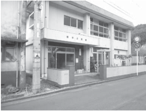
写真 21 雨井公民館前の 3.2m の標識のある電柱
