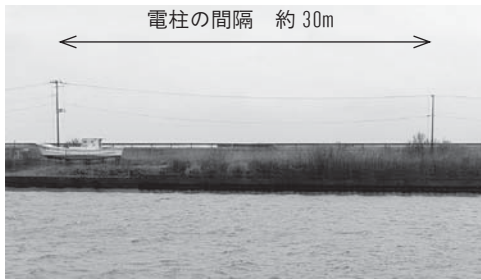
写真 2 電柱の間隔 30m
