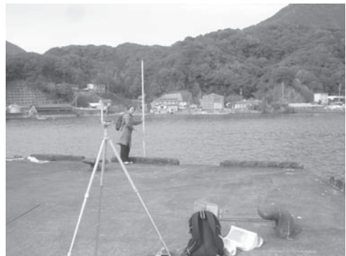
写真 1 尾鷲漁港での測量作業
