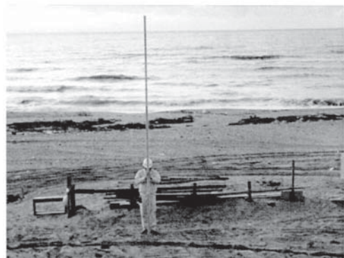
写真 4 十里塚沿岸道路面の標高測定点
