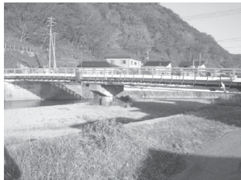
写真 26 大岩川の旧街道橋 測定点は写真手前の平地
