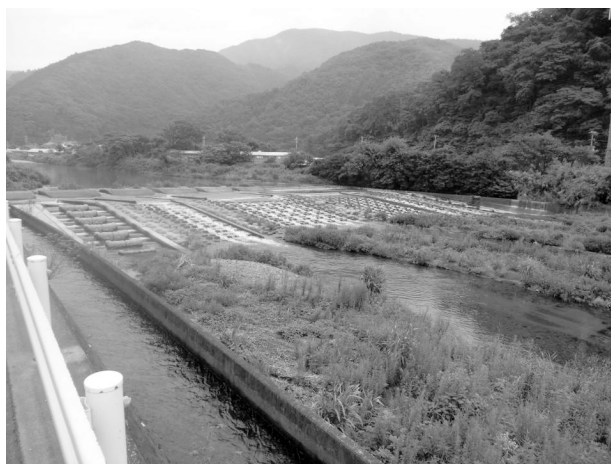
写真 1 現在の西伊豆町仁科の寺川大堰
