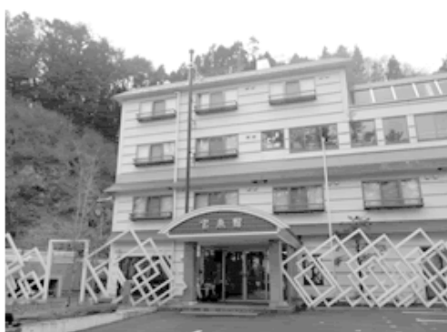
写真-6 津波避難ビル指定宝来館
