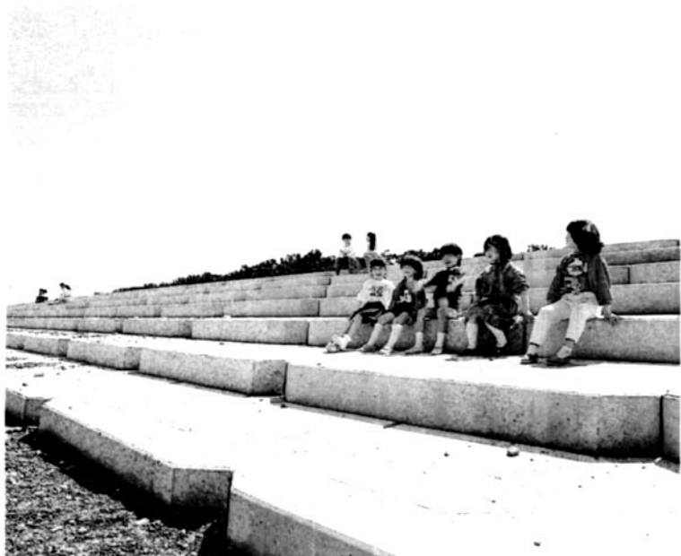
写真-2 海水浴客等が迅速に海岸から避難できるよう階段状になっている海岸堤防。 ベンチ代わりにも活用される。(清水市真崎海水浴場)
