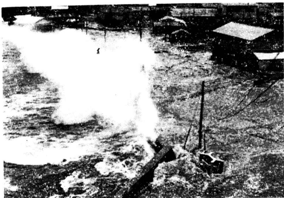
写真-2 燕島防波護岸に打上がった津波（細越氏撮影）
