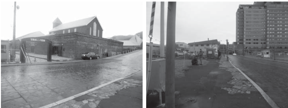
図-3.7 築島における測定地点
