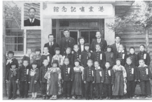
写真 29 港震嘯記念館
