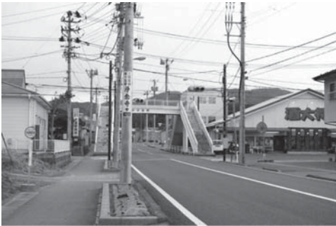
写真 40 三ノ浜（西みなと町）震嘯記念館跡（鹿折歩道橋と周辺）
