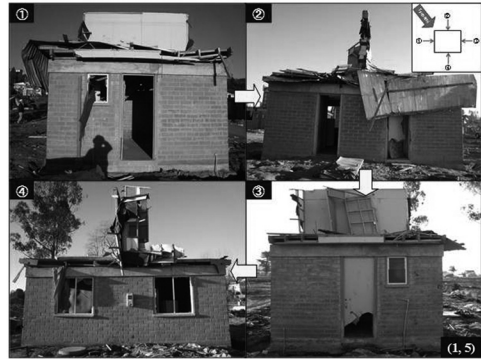
図-9 建物の被災状況写真例
