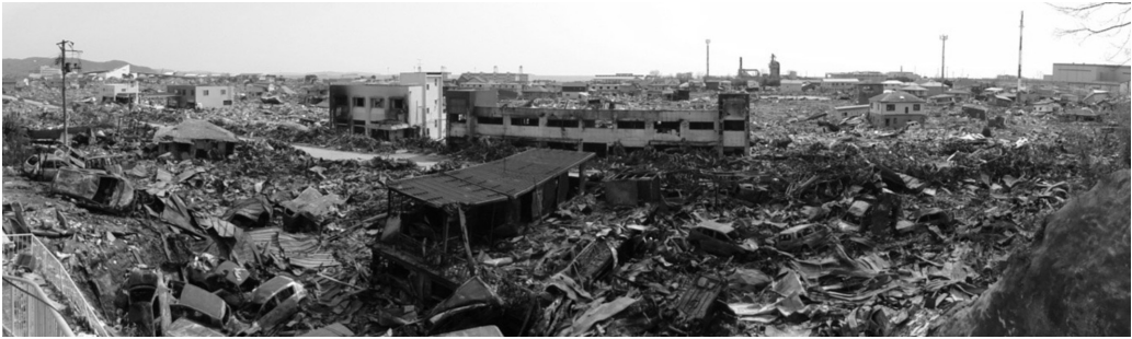
写真-1 石巻市南浜・門脇地区の被害状況
