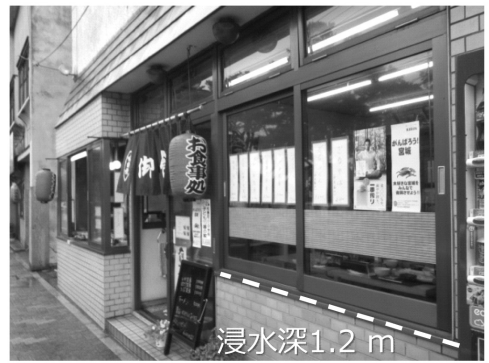
写真-3 松島市の浸水状況
