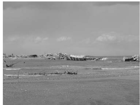
(b) 崩壊した海岸構造物 (山元町)
