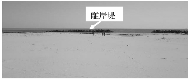
図-2 測線 A (仙台市荒浜付近) の海岸の様子. 離岸堤の大規模損壊や砂浜消失は見受けられない.
