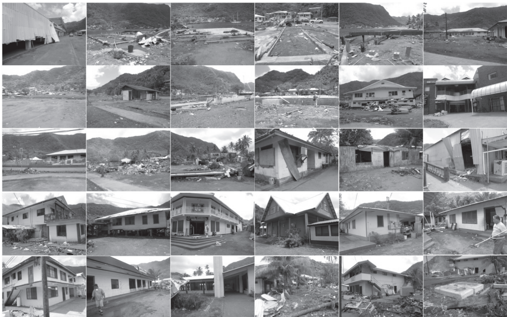
写真6 GPSカメラで撮影したPago Pago市街地の建物被害状況の例。
