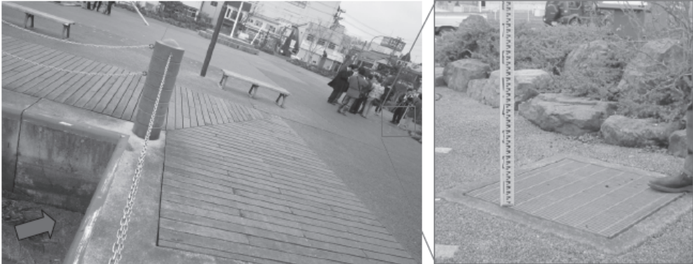
写真 6 排水柵からの浸水 (左：海面下の水路から浸入，右：海水が流出した箇所)
