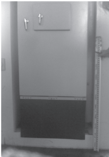
写真 1 電源盤による浸水高さの測定
