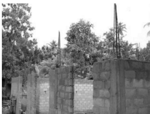
(2) 幼稚園建設現場 (下記)
