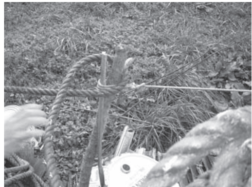
図 11. ビット②の係留ロープの巻き方 (比較的弱く)
