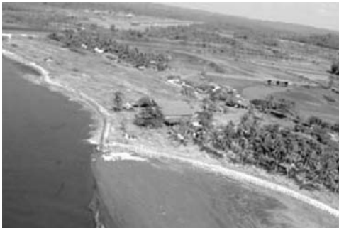
写真-1 津波で建物が破壊された中部ジャワ州チラチャップの海岸=アンタラ通信
