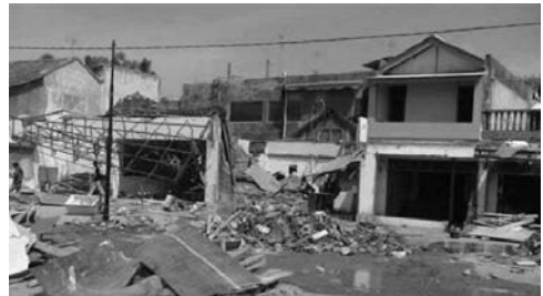
写真-2 Pangandaran での家屋被害
