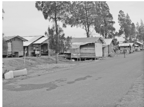
写真-12 河川堤防の上に簡易的な住居が立ち始めた（バンダアチェ）
