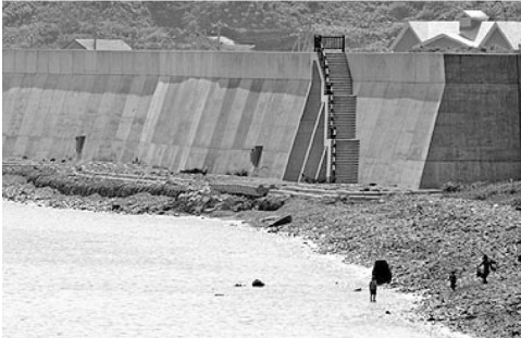
写真-5 奥尻島沿岸部に建設された防潮堤
