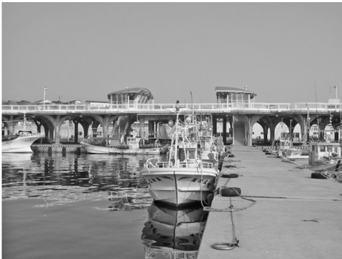
写真-6 奥尻島青苗港での人工地盤（日常と非常時の際に利用できる）
