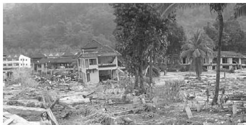
写真6 地盤が流され、大破に至った建物
