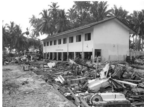
写真一 5 残された建物（高校の校舎）（スリランカ）
