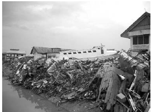
写真-1 インドネシア、バンダアチェでの被災状況 (アジア防災センター 荒木田勝氏撮影)
