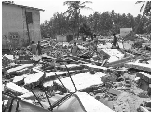
写真一 4 破壊された住宅（スリランカ）
