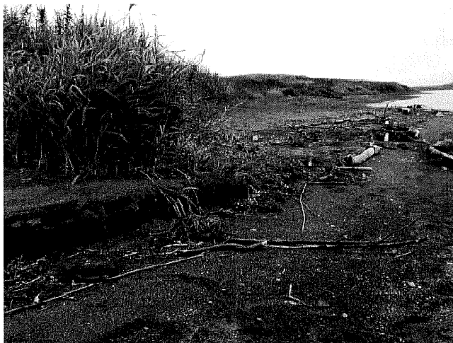
図 219-1 材などの浮遊物による水位上昇の痕跡
