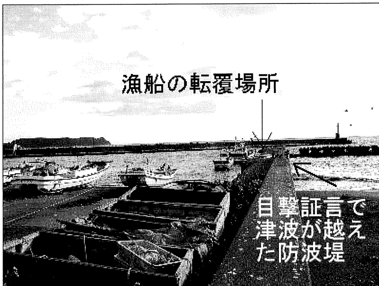
図 180-1 津波高を測定した床潭の西防波堤
