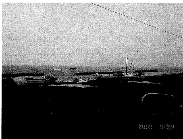
図 184-2 調査地点沖の波消しブロック
