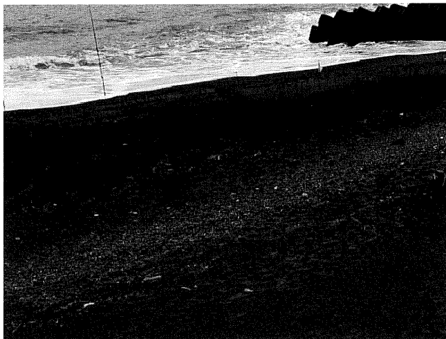
図 88-1 津波が遡上した痕跡
