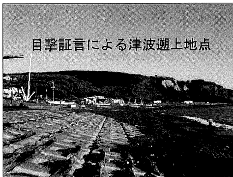
図 186-1 末広の船揚場の津波遡上地点
