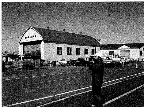
図 119-1 外壁に浸水線が残っていた造船所
