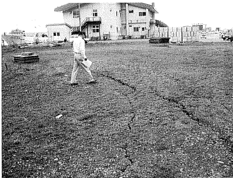
図 49-1 十勝港の岸壁付近倉庫
