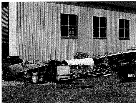
図 119-2 外壁の浸水線
