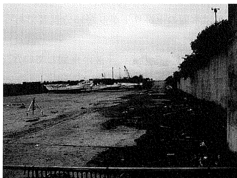
図 87-1 浜大樹港内に残された津波の痕跡
