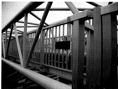
図 170-2 釧路町水管橋
