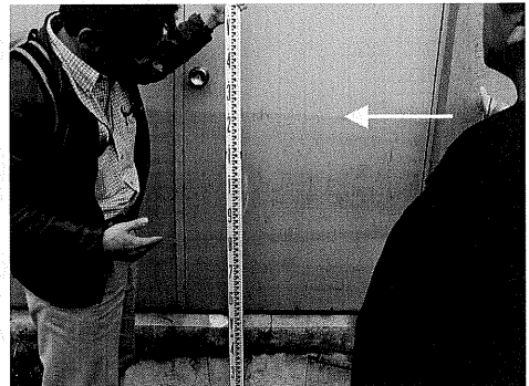
図 51-1 津波が運び込んだと思われる泥が乾燥した細かな砂粒子が残されている。
