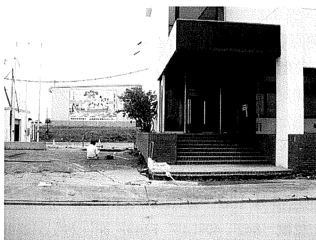
写真 140-2 大津漁港岸壁から津波痕跡地点を見る
