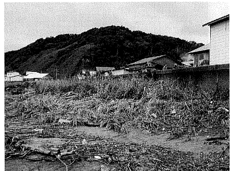
図 147-2 消波ブロックの海岸堤防側
