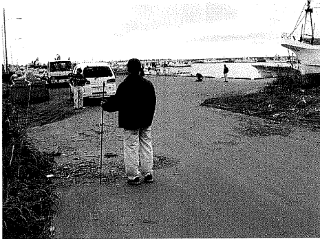
図 151-1 厚内漁港内道路上の津波痕跡
