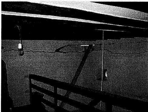
写真-11 屋内に侵入した津波によって天井が持ち上げられた跡 (Ficogrande, 2003年3月19日撮影)
