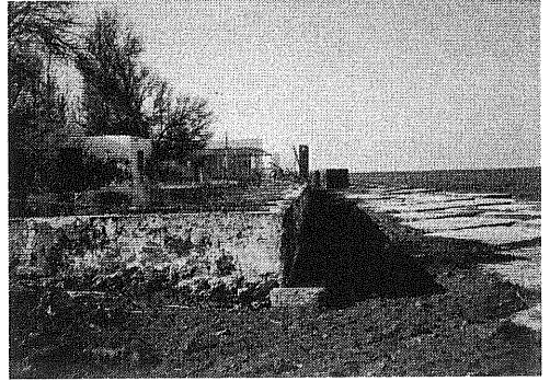
写真-7 津波に倒されたフェンス (Pta. Lena, 2003年3月20日撮影)
