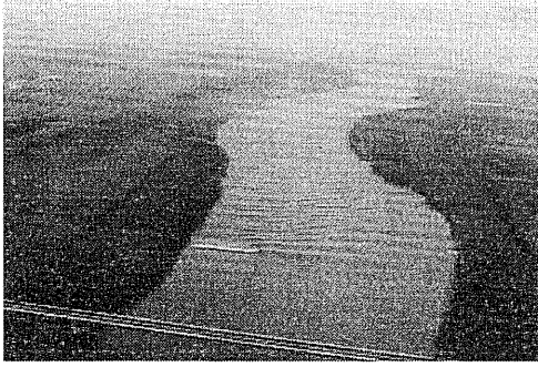
写真-1 ソリトン波列を伴い十勝川を遡上する津波（陸上自衛隊北部方面隊撮影。2003年9月26日AM6:25頃、十勝川河口橋付近（k.p.5.7付近）より河口方向を望む）
